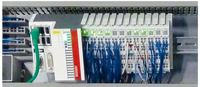
Mit dem Embedded-PC CX5010 und den EtherCAT-Klemmen wurde ein leistungsfähiges und extrem kompaktes Steuerungssystem realisiert.
