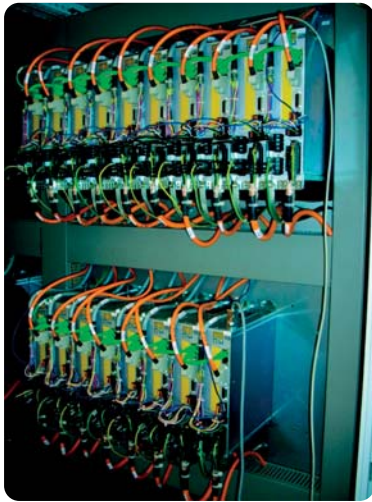
Bild 3: Die digitalen Servoverstärker Kollmorgen S700 steuern im Schaltschrank der Firma Koch Pac-Systeme bis zu 50 Servoachsen an.
