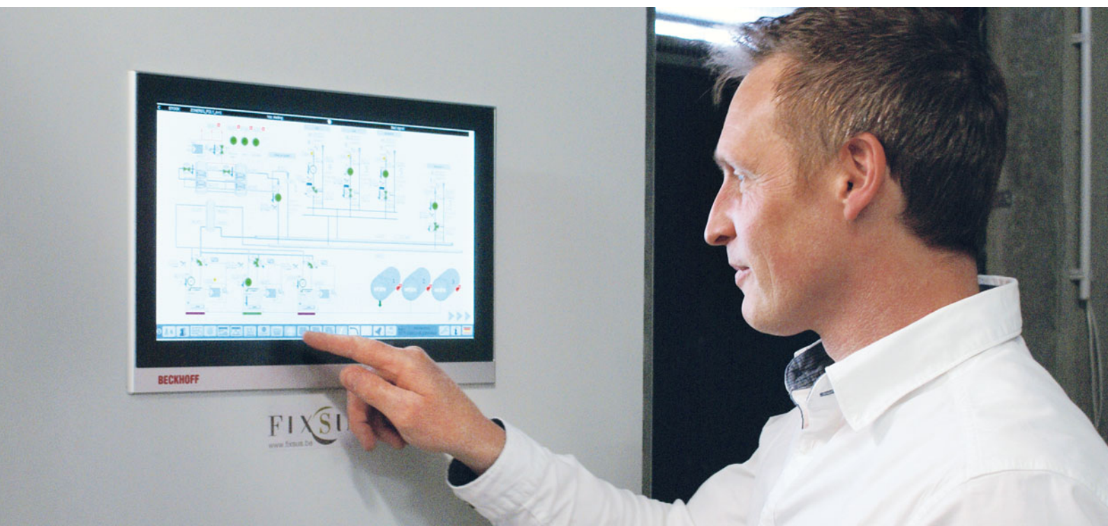
Koen Verschuere, Geschäftsführer von FixSus, nimmt finale Einstellungen des Gebäudemanagementsystems am Widescreen-Multitouch-Panel vor.
