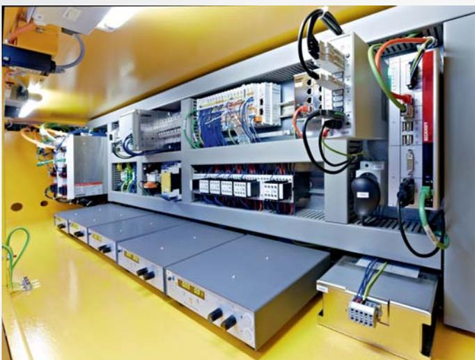
Jede der 91 Undulatorzellen wird durchgängig per PC-based Control gesteuert: über einen Schaltschrank-PC C6925 (rechts), zahlreiche EtherCAT-Klemmen (Mitte) sowie zwei Servoverstärker AX5206 (links).
